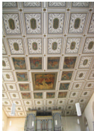
Die Kassettendecke im Langhaus, im Mittelfeld die Trinität.
